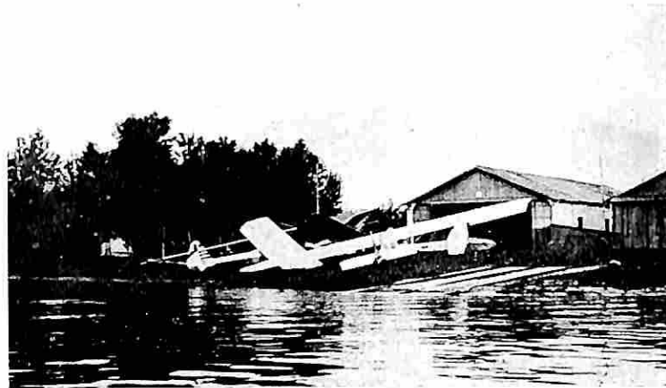
Fig. 16 - Di mano in mano che gli alianti ammaravano venivano recuperati da un motoscafo ed ammassati davanti alle aviorimesse dell'idroscalo della Schiranna.
