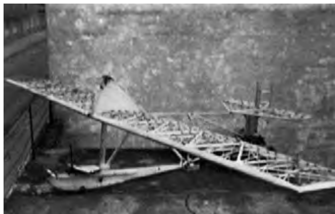
Montaggio dello Zoegling sul terrazzo del garage
