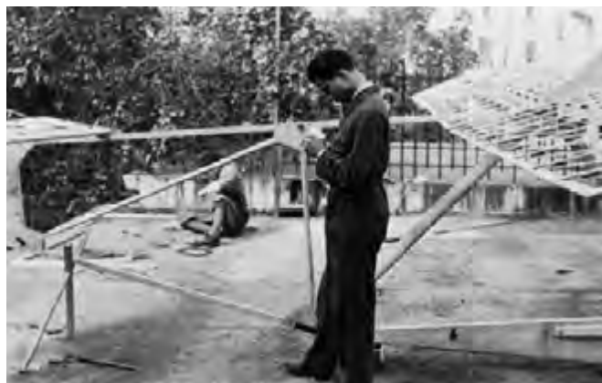
La costruzione dello Zoegling -Dario Tognazzi
