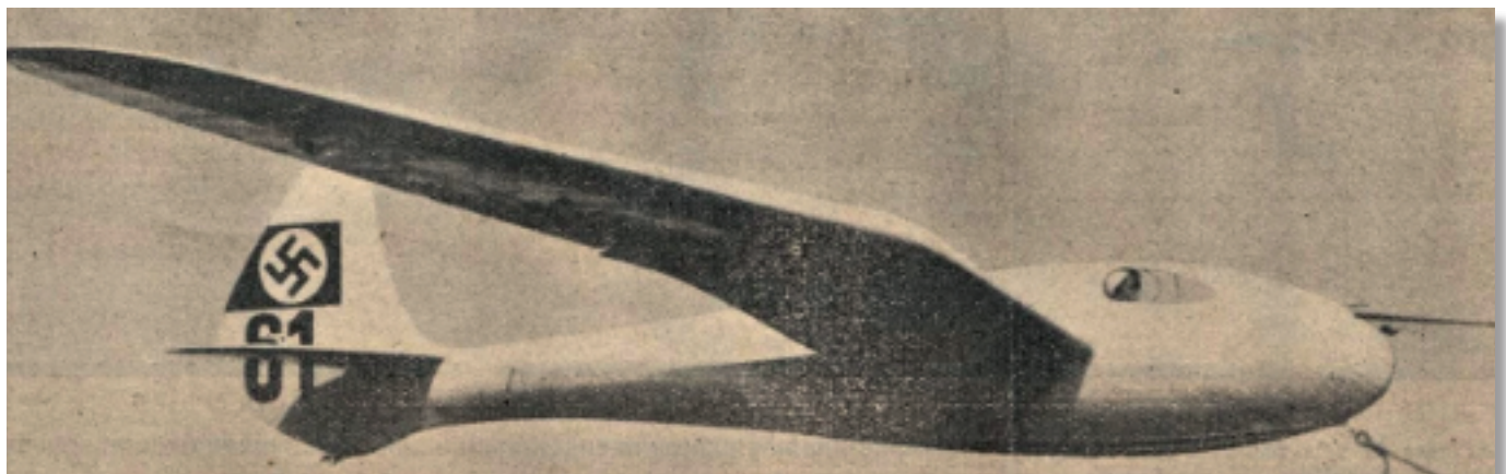
L'aliante Sperber Junior costruito appositamente per la Reitsch. L'abitacolo era minuscolo, l'apertura alare allungata di 60 cm più altre migliorie ai raccordi tra le superfici
