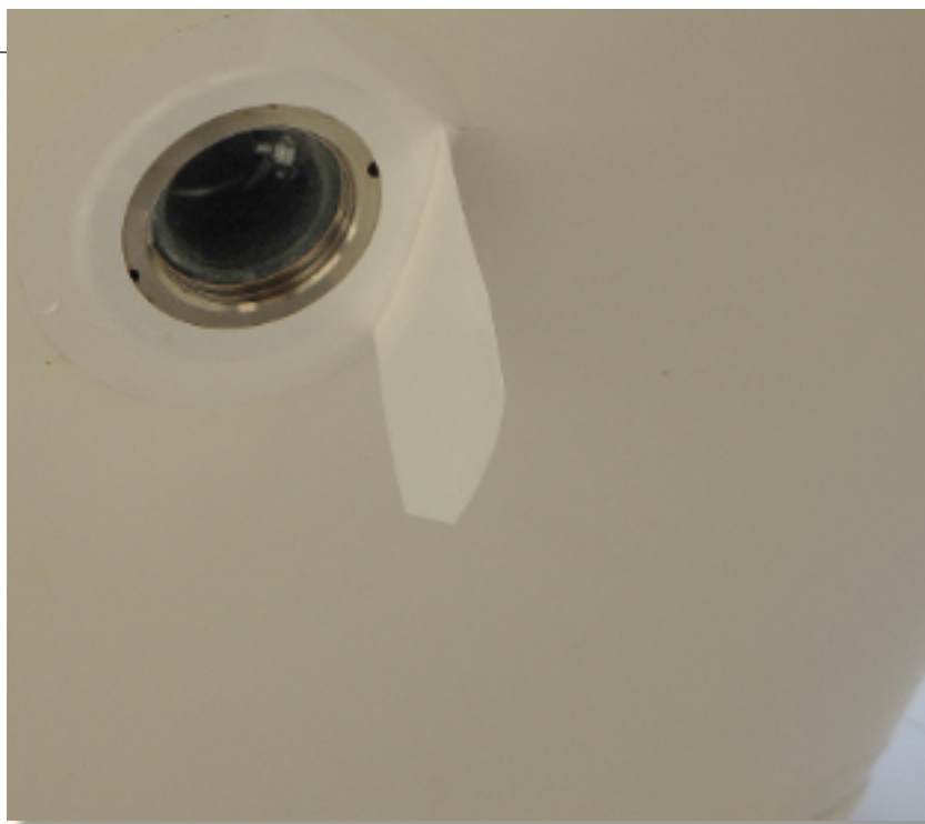
Sigillatura mobile dello scarico di zavorra
