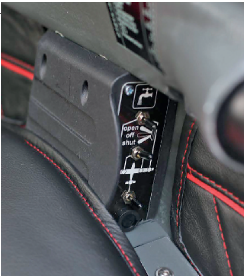
Il piccolo pannello di controllo delle elettrovalvole (scarico ballast)
